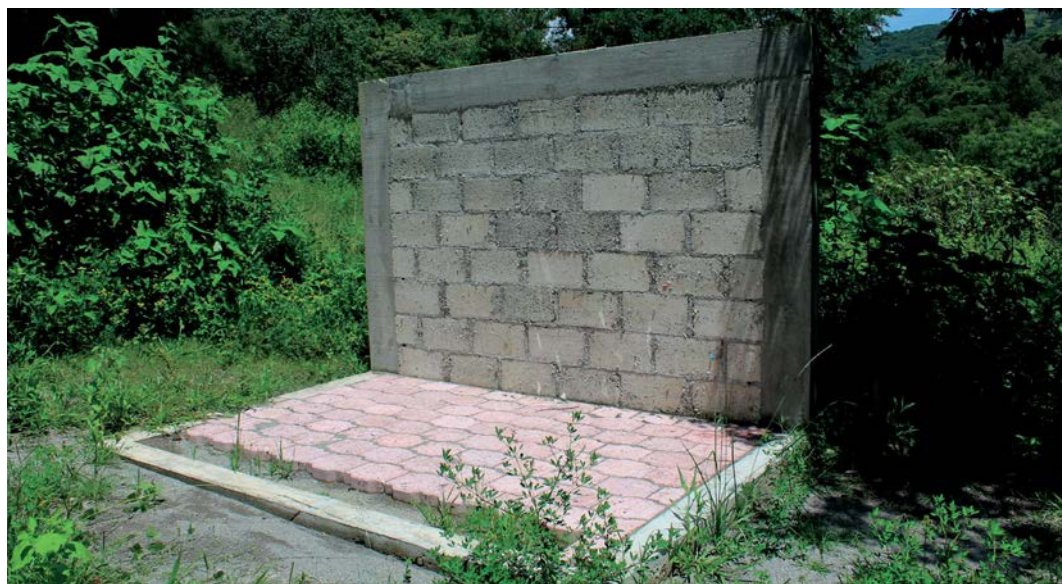
Fotografía: Construcción de la planta de transformación de residuos sólidos, Ixtapan de la Sal.
